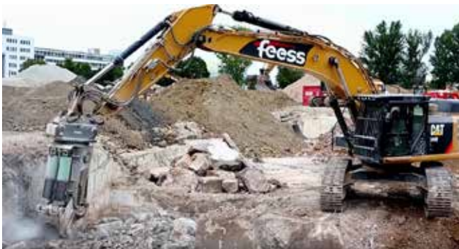
Egli-Betonbeisser im Einsatz bei Feess
